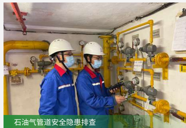
石油气罐井气体检测与泄露检查
